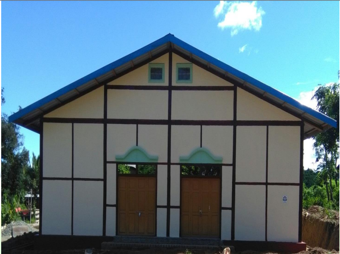
တတိယနှစ်တွင်အကောင်အထည်ဖော်ဆောင်ရွက်သည့် ခန်းမဆောင်ဆောက်လုပ်ခြင်းမှတ်တမ်းဓာတ်ပုံ
