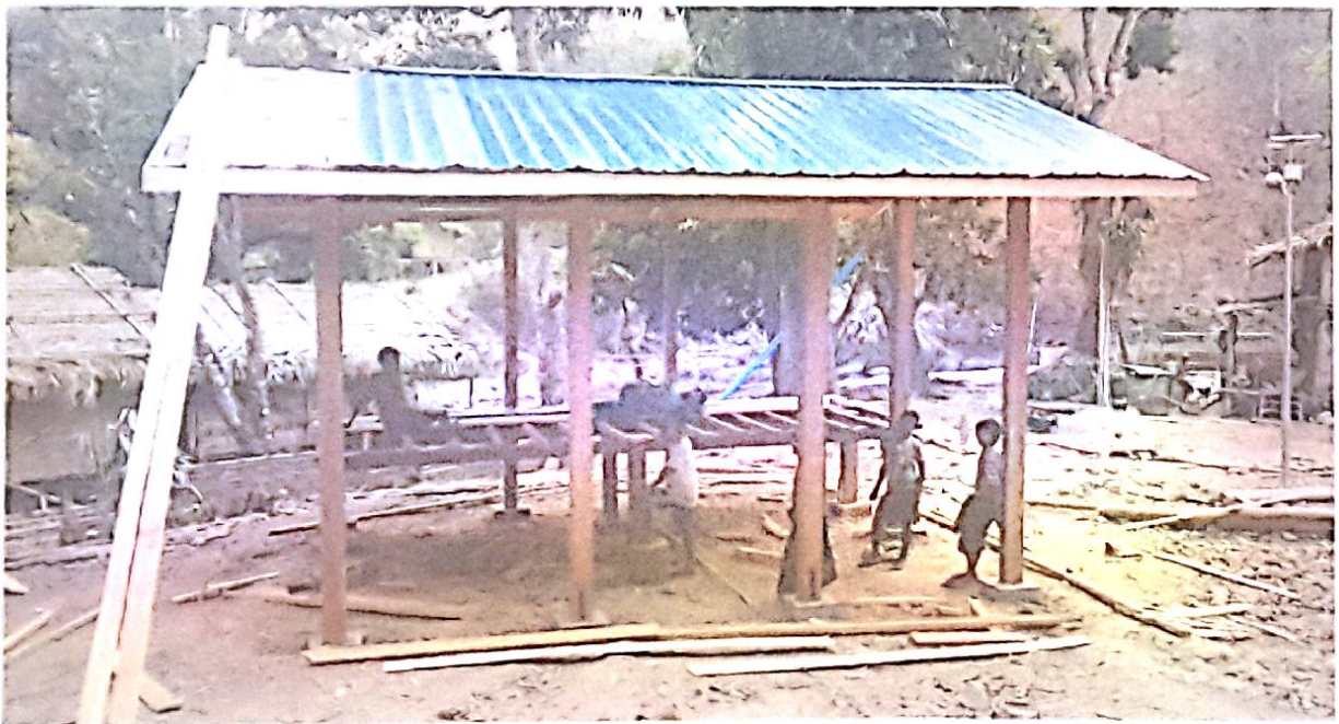
မင်းတာကျေးရွာ ရွာလယ်ဇရပ် တည်ဆောက်နေစဉ်
