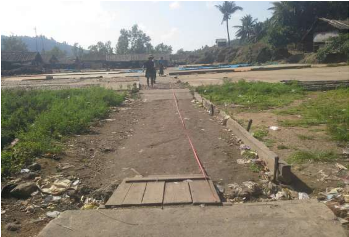
စိမ့်ကိန်းလုပ်ငန်းခွဲ (ကွန်ကရစ်လမ်း) မြေနေရာအား တိုင်းတာခြင်း
