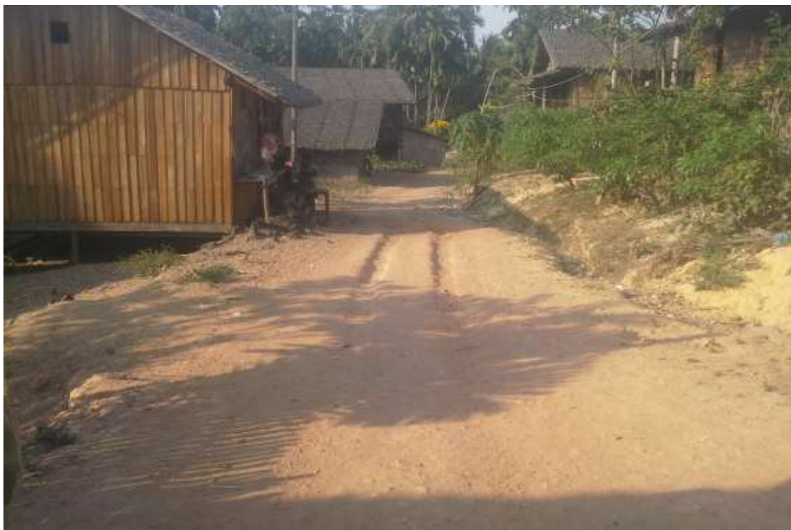
ကွန်ကရစ်ခင်းမည့် လမ်းနေရာ
