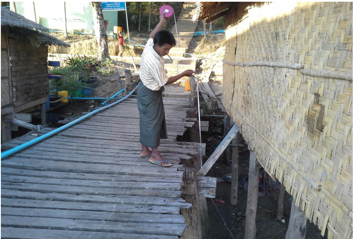
စီမံကိန်းလုပ်ငန်းခွဲပြုလုပ်မည့်နေရာအား တိုင်းတာခြင်း (ဆိပ်ခံတံတား ပြုပြင်ခြင်း)
