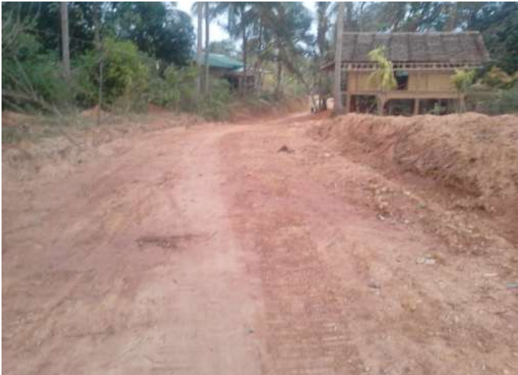
ကွန်ကရစ်ခင်းမည့် လမ်းနေရာ
