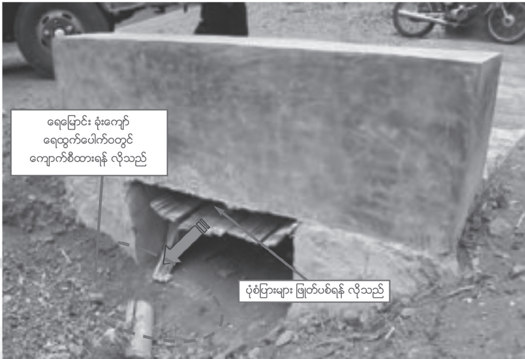
ပုံစံပြားများ ဖြတ်ပစ်သဖြင့် အမှိုက်ပိတ်ဆို့ကာ အသုံးမဝင် ဖြစ်သွားနိုင်သည်
