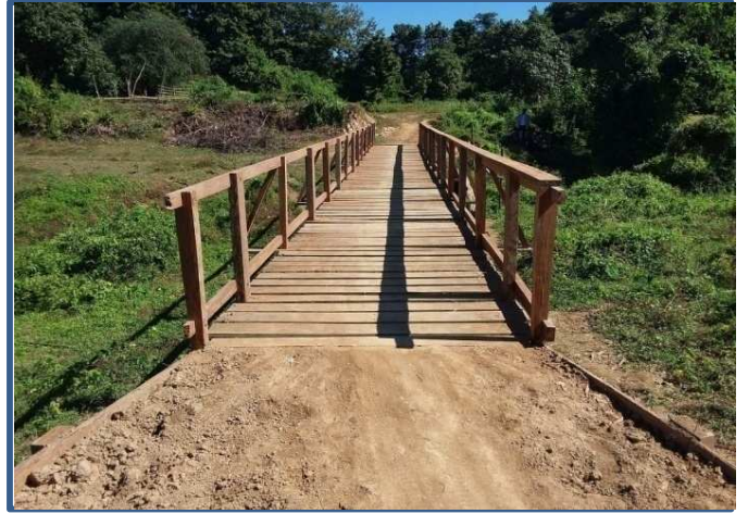
အမ်းမြို့နယ် နတ်မော်ကျေးရွာ သစ်သားတံတားတည်ဆောက်ခြင်း
