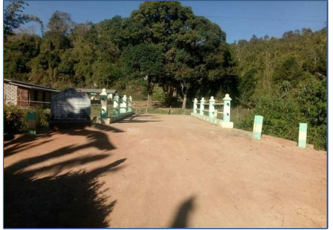
ဆီဆိုင်မြို့နယ် ပန်ဟိုင်းကျေးရွာ ကွန်ကရစ်တံတားတည်ဆောက်ခြင်း
