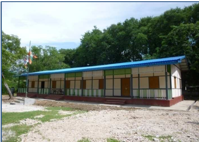
တပ်ကုန်းမြို့နယ် အဆုံဖီးကုန်းကျေးရွာ စာသင်ကျောင်းဆောင်တည်ဆောက်ခြင်း
