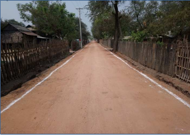
မြောင်မြို့နယ် ပရိမ္မကျေးရွာ ကျောက်ချောလမ်းခင်းခြင်း
