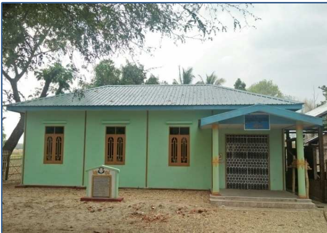
ကြံခင်းမြို့နယ် ကြပ်ကလေးကျေးရွာ ကျေးရွာခန်းမဆောင်တည်ဆောက်ခြင်း
