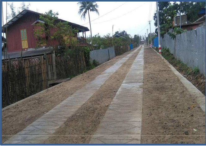
မိုးကောင်းမြို့နယ် ရွာသာကုန်းကျေးရွာ ကွန်ကရစ်ဘီလမ်းလမ်းဖောက်လုပ်ခြင်း
