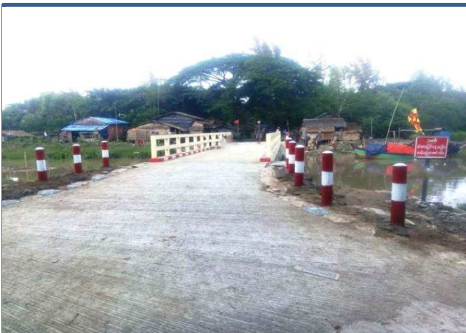
ကော့မှူးမြို့နယ် ညောင်ကုန်းကျေးရွာ ကွန်ကရစ်တံတားတည်ဆောက်ခြင်း
