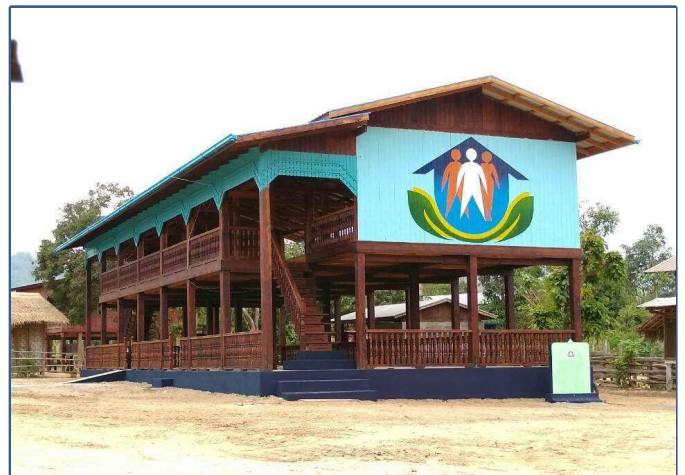
ဗန်းမောက်မြို့နယ် ခမိုးကျေးရွာ ကျေးရွာခန်းမဆောင်တည်ဆောက်ခြင်း
