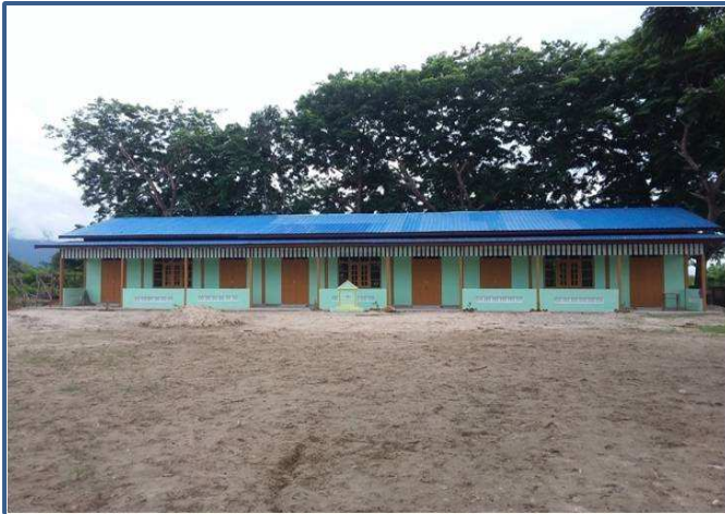
မိုးကောင်းမြို့နယ် နန်းခွင်ကျေးရွာ စာသင်ကျောင်းဆောင်တည်ဆောက်ခြင်း
