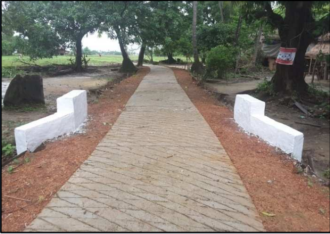
ကျောက်ကြီးမြို့နယ် ပေါက်သတောကျေးရွာ ကွန်ကရစ်လမ်းခင်းခြင်း
