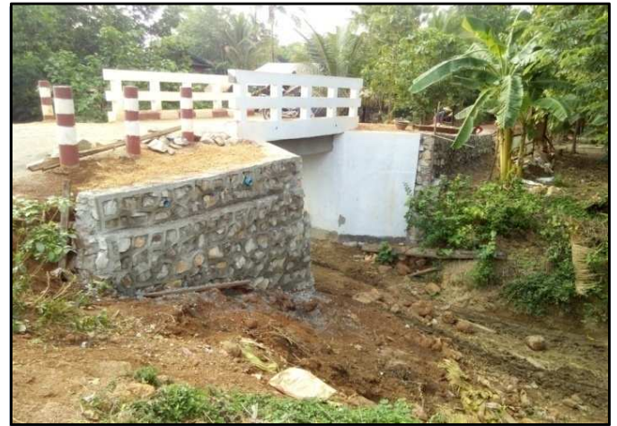
ကျောက်ကြီးမြို့နယ် ဒုံးတိုကျေးရွာ ကွန်ကရစ်တံတားတည်ဆောက်ခြင်း
