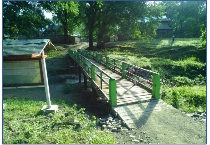
စေတုတ္ထရာမြို့နယ် မဟောတောင်ကျေးရွာ သစ်သားတံတားတည်ဆောက်ခြင်း
