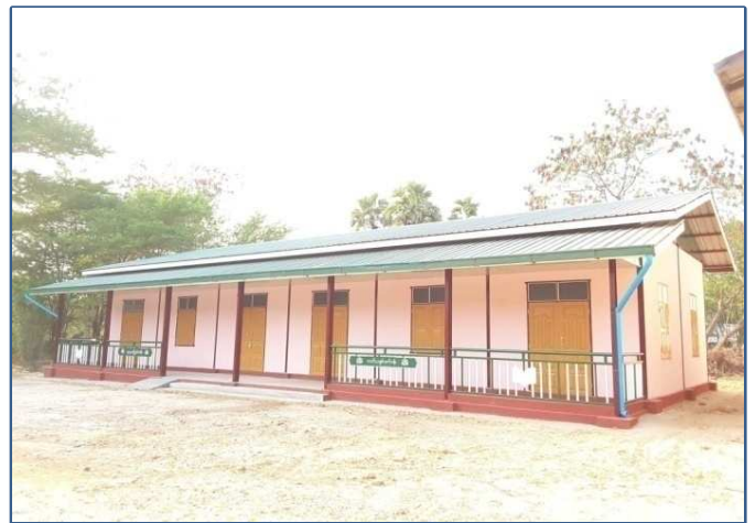
ညောင်ဦးမြို့နယ် အနောက်အုံကျေးရွာ စာသင်ကျောင်းဆောင်တည်ဆောက်ခြင်း
