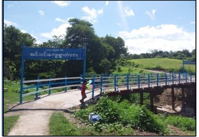
ပန်းတောင်းမြို့နယ် အင်းဝင်ကျေးရွာ တံတားတည်ဆောက်ခြင်း
