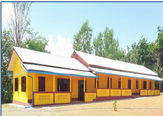
တနင်္သာရီမြို့နယ် လမိုင်းကျေးရွာ စာသင်ကျောင်းဆောင်တည်ဆောက်ခြင်း
