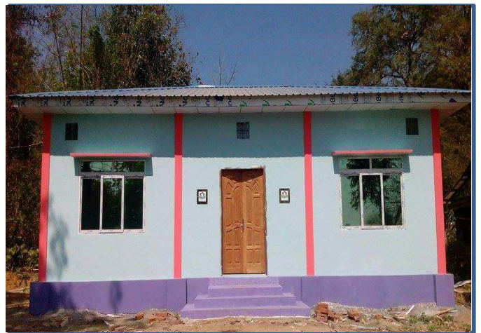
လေးမျက်နှာမြို့နယ် ချင်းလယ်ကျေးရွာ ကျေးရွာခန်းမဆောင်တည်ဆောက်ခြင်း
