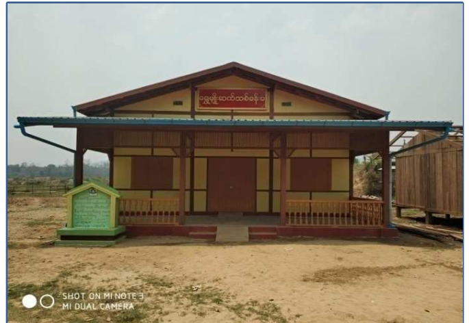
ဗန်းမောက်မြို့နယ် မဲတောကျေးရွာ ကျေးရွာခန်းမဆောင်တည်ဆောက်ခြင်း
