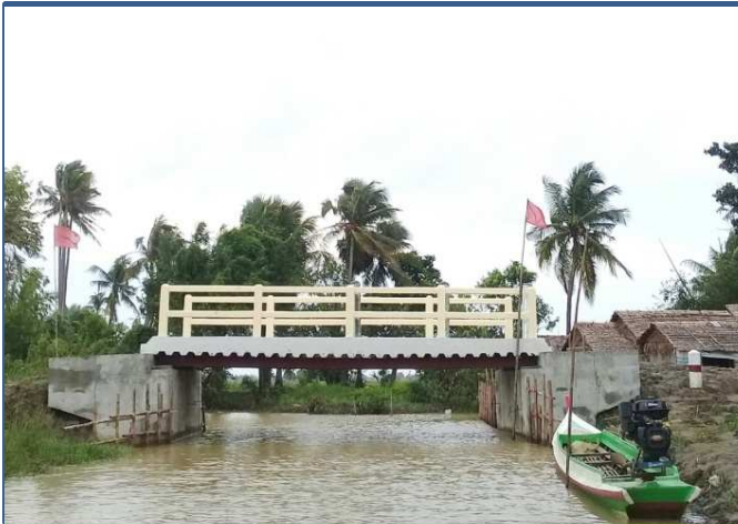
ကွန်းခြံကုန်းမြို့နယ် အခါတ်ဆိပ်ကျေးရွာ ကွန်ကရစ်တံတားတည်ဆောက်ခြင်း
