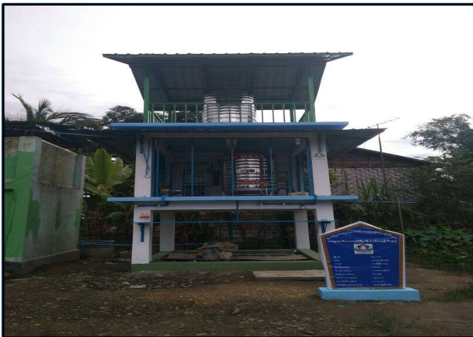
ပန်းတောင်းမြို့နယ် သောင်ကြီးကျေးရွာ ရေသန့်စက်တည်ဆောက်ခြင်း
