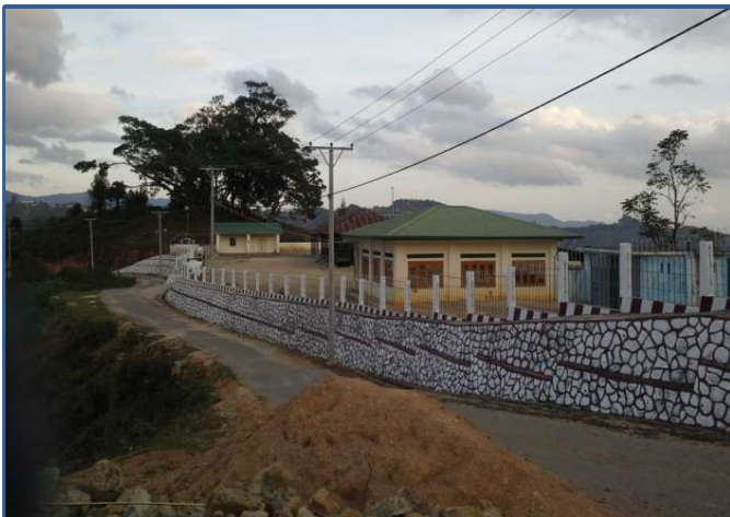
နမ့်ဆန်မြို့နယ် ဝေမိန်းကျေးရွာ စာသင်ကျောင်းမြေကာနံရံတည်ဆောက်ခြင်း
