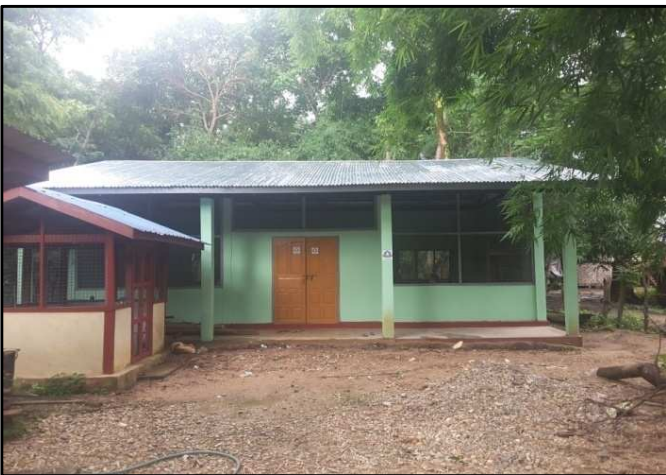
ကျောက်ကြီးမြို့နယ် တမာခေါကျေးရွာ လူထုနားနေဆောင်တည်ဆောက်ခြင်း
