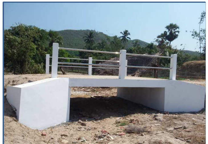
ပေါင်မြို့နယ် ကန်ဖြူကျေးရွာ ကွန်ကရစ်တံတားတည်ဆောက်ခြင်း
