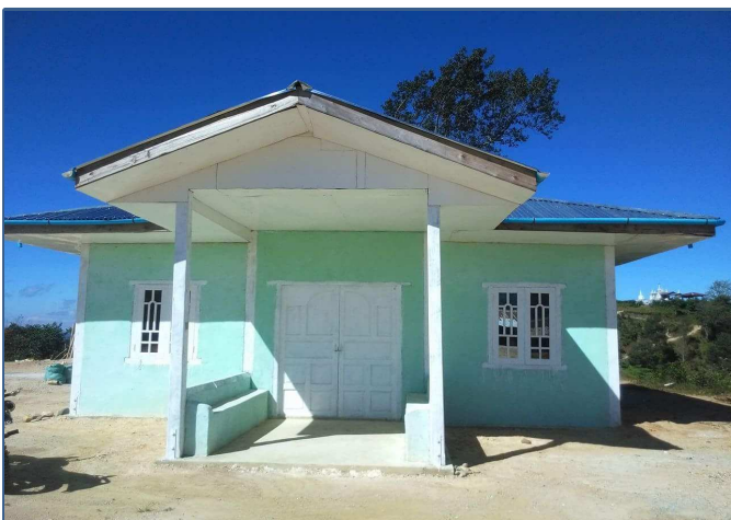
နမ့်ဆန်မြို့နယ် မန်စပ်ကျေးရွာ ကျေးလက်ဆေးပေးခန်းတည်ဆောက်ခြင်း
