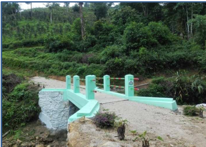
နမ့်ဆန်မြို့နယ် မန်ဆာကျေးရွာ ကွန်ကရစ်တံတားတည်ဆောက်ခြင်း
