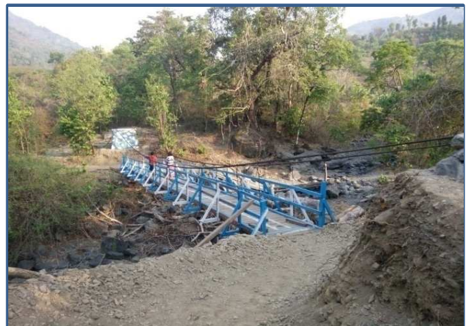
မတူပီမြို့နယ် ရုန်းကျေးရွာ လူကူးကြိုးတံတားတည်ဆောက်ခြင်း
