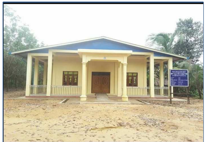
ကြာအင်းဆိပ်ကြီးမြို့နယ် ကျုံခဝန်ကျေးရွာ ကျေးရွာခန်းမဆောင်တည်ဆောက်ခြင်း
