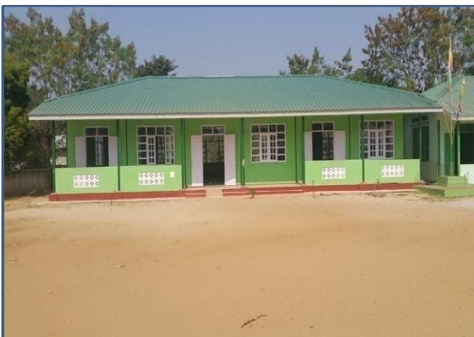
ဝါန်းဇွန်မြို့နယ် သာပေါင်းကျေးရွာ စာသင်ကျောင်းဆောင်တည်ဆောက်ခြင်း
