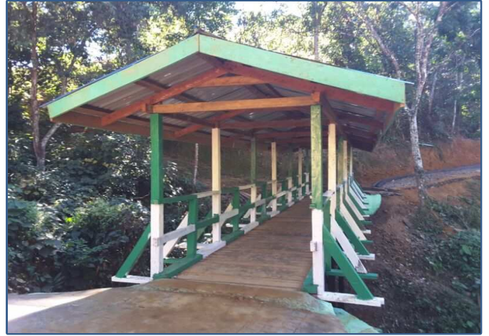
ပလက်ဝမြို့နယ် ကျီးလေ(အထက်)ကျေးရွာ သစ်သားတံတားတည်ဆောက်ခြင်း
