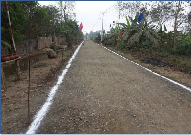
ကြံခင်းမြို့နယ် ကြံတောကျေးရွာ ချောင်းကျောက်လမ်းခင်းခြင်း
