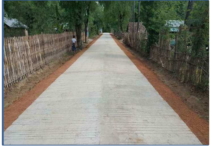
ပေါက်မြို့နယ် ညောင်ပင်တိုက်ကျေးရွာ ကွန်ကရစ်လမ်းခင်းခြင်း
