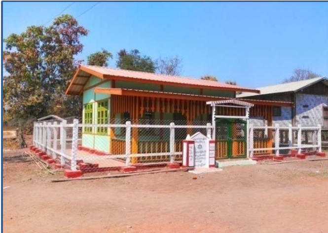
ပင်လည်ဘူးမြို့နယ် ကျည်ပွေ့သလင်းကျေးရွာ ကျေးရွာစာကြည့်တိုက်တည်ဆောက်ခြင်း
