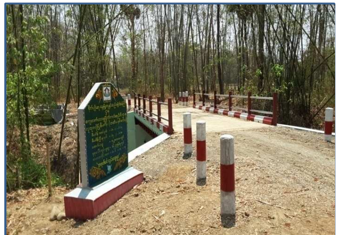
ကြံခင်းမြို့နယ် သရက်ပင်ကွင်းကျေးရွာ ကွန်ကရစ်တံတားတည်ဆောက်ခြင်း
