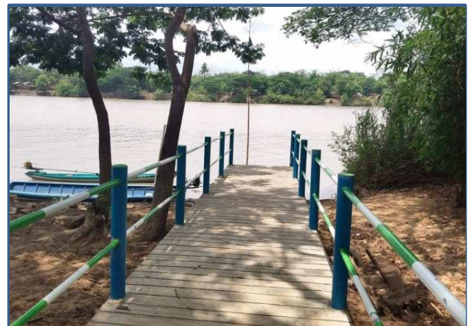
ထန်းတပင်မြို့နယ် ညောင်ဆိပ်ကျေးရွာ ရေဆိပ်ဆင်းတံတားတည်ဆောက်ခြင်း
