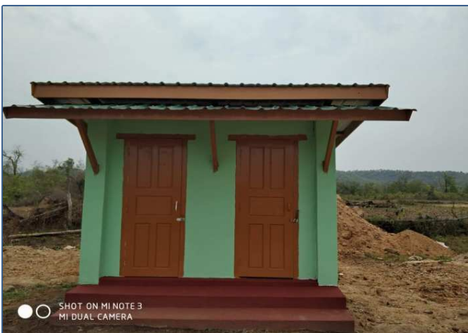
ဗန်းမောက်မြို့နယ် တာမကျိုင်းကျေးရွာ ကျောင်းရေလောင်းအိမ်သာတည်ဆောက်ခြင်း
