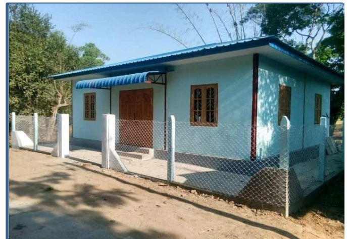
ထန်းတပင်မြို့နယ် အနောက်စုကျေးရွာ ကျေးရွာစာကြည့်တိုက်တည်ဆောက်ခြင်း
