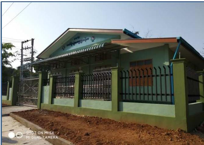
ချောင်းဆုံမြို့နယ် ရွာလွတ်ကျေးရွာ ကျေးရွာခန်းမဆောင်တည်ဆောက်ခြင်း
