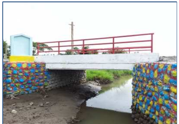
ဆောမြို့နယ် ရဲရင့်ကျေးရွာ ကွန်ကရစ်တံတားတည်ဆောက်ခြင်း
