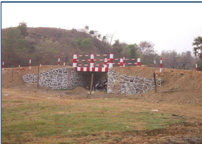
ရမည်းသင်းမြို့နယ် အေးရိပ်မြိုင်ကျေးရွာ ကွန်ကရစ်တံတားတည်ဆောက်ခြင်း
