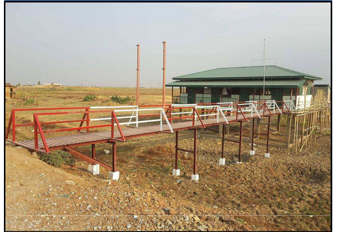
မိုးညိုမြို့နယ် သရက်ကုန်းကျေးရွာ စာသင်ကျောင်ဆောင်တည်ဆောက်ခြင်း
