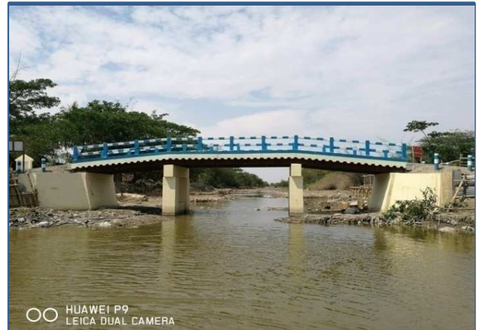
ကျောက်တန်းမြို့နယ် တမံကြီးကုန်းကျေးရွာ ကွန်ကရစ်တံတားတည်ဆောက်ခြင်း
