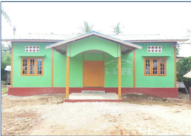
မင်းတုန်းမြို့နယ် သဖန်းကိုင်းကျေးရွာ ကျေးရွာခန်းမဆောင်တည်ဆောက်ခြင်း
