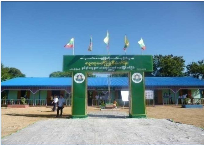
တပ်ကုန်းမြို့နယ် နွယ်ရစ်ကျေးရွာ စာသင်ကျောင်းဆောင်တည်ဆောက်ခြင်း
