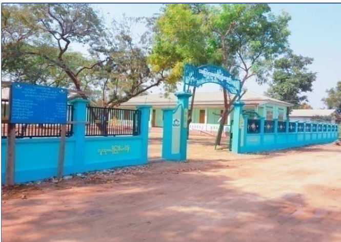
မြောင်မြို့နယ် ကျောက်ရစ်(အရှေ့)ကျေးရွာ စာသင်ကျောင်ခြံစည်းရိုးလုပ်ငန်း
