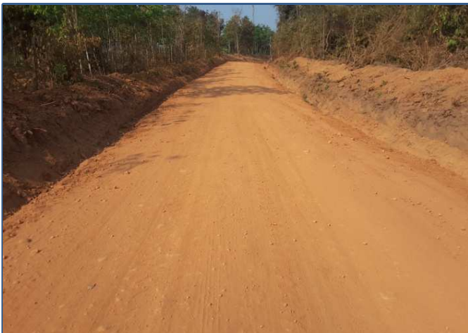
ကြာအင်းဆိပ်ကြီးမြို့နယ် ထီးဝါးကလူးကျေးရွာ ဂဝံလမ်းဖောက်လုပ်ခြင်း
