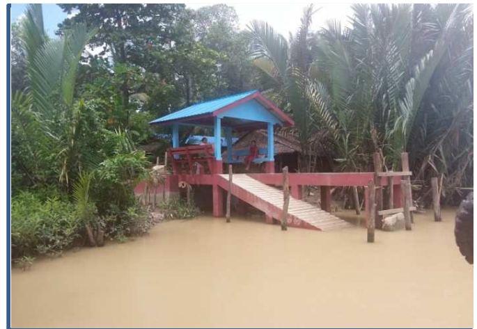
ဇယုတောမြို့နယ် မြက်တိုပဲကြီးကျေးရွာ ဆိပ်ခံတံတားတည်ဆောက်ခြင်း
