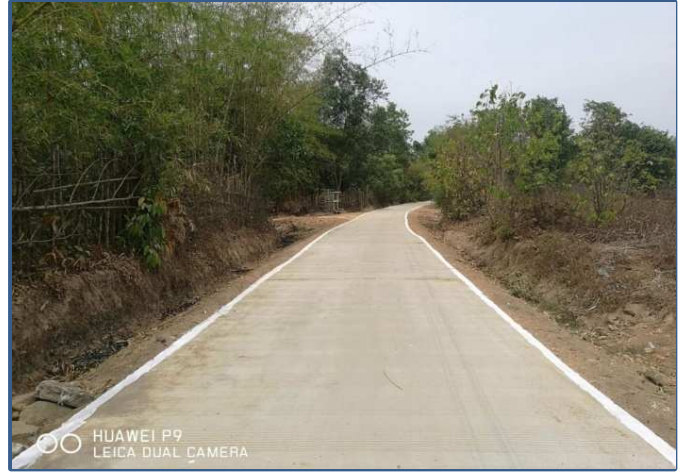
ကျောက်တန်းမြို့နယ် ရှမ်းစုကျေးရွာ ကွန်ကရစ်လမ်းခင်းခြင်း
