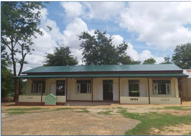
နွားထိုးကြီးမြို့နယ် သနပ်ခါးတောကျေးရွာ စာသင်ကျောင်းဆောင်တည်ဆောက်ခြင်း
