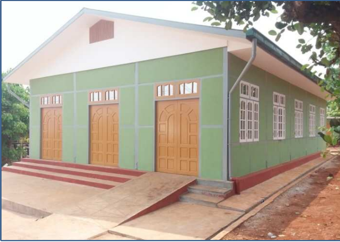
လွိုင်ကော်မြို့နယ် မိုက်ကန်းကျေးရွာ ခန်းမဆောင်တည်ဆောက်ခြင်း
