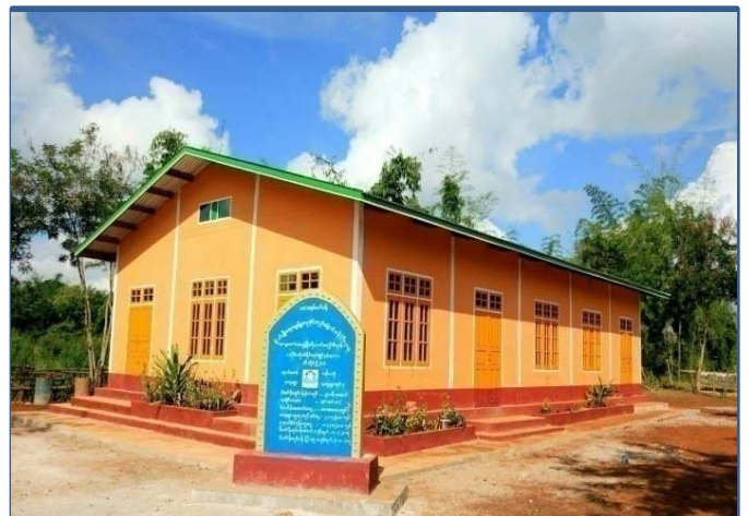
ဆီဆိုင်မြို့နယ် လွယ်တော်ကျေးရွာ ကျေးရွာခန်းမဆောင်တည်ဆောက်ခြင်း
